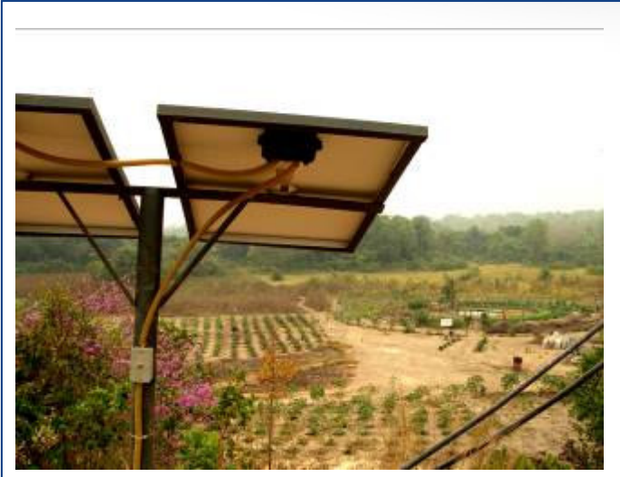
Utilização de sistema fotovoltaico de energia solar
